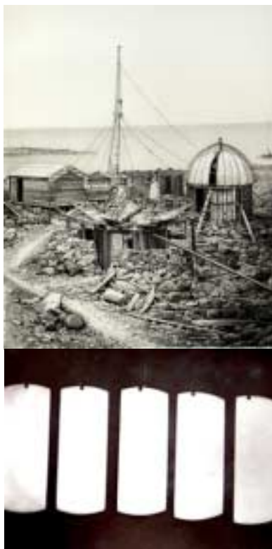
Installations françaises en île Saint Paul, et des photographies du transit réalisées lors de cette expédition.
