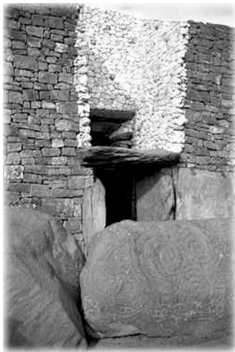
Entrée de la tombe de Newgrange : l'ouverture ménagée pour laisser entrer la lumière solaire est clairement visible.
